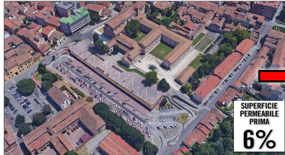
FORLÌ Stato Attuale (Google Earth)
